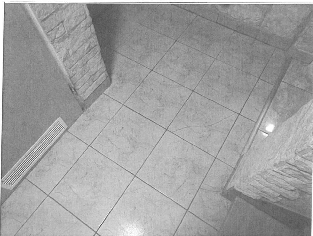
Pęknięte płytki podłogowe (piwnica budynku nr 143)
