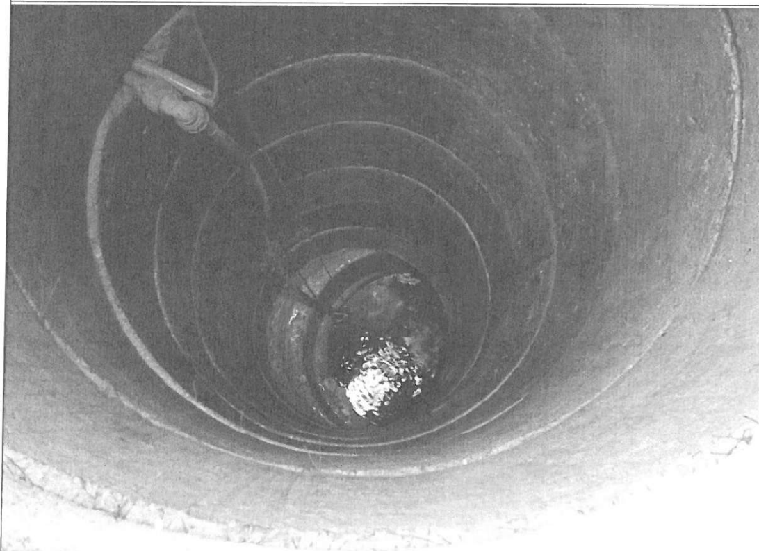
Studnia na posesji nr 171 z widocznym przemieszczeniem na głębokości 4 m
