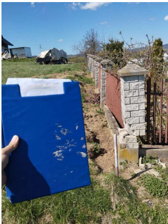
Rys.5. Pęknięty słup ogrodzenia domu nr 143
