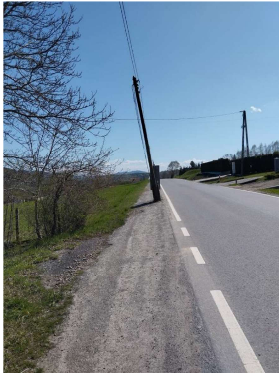
Rys.7. Pochylone słupy wzdłuż drogi przy kartowanym osuwisku
