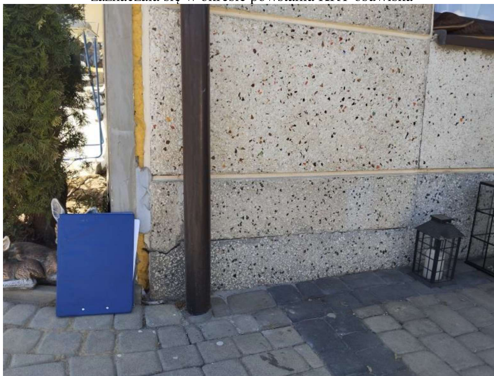
Rys. 2. Pęknięcie w elewacji w domu nr 143
