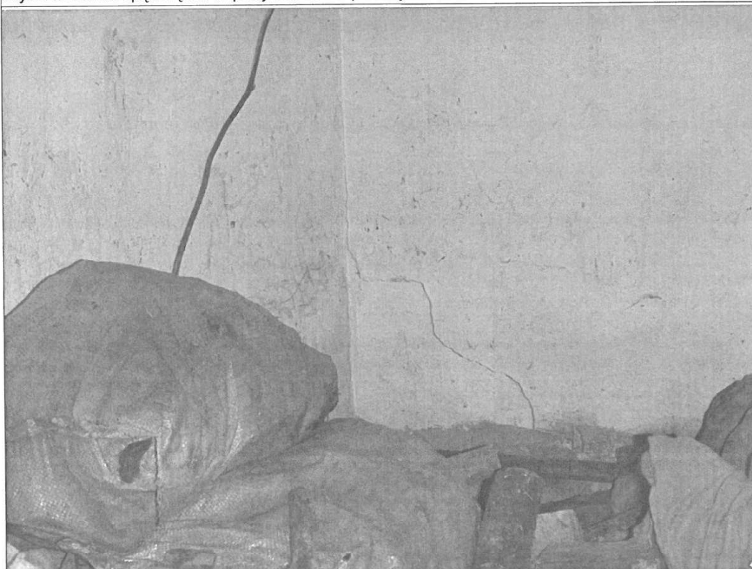
Pęknięcia w ścianie kotłowni (budynek nr 143)
